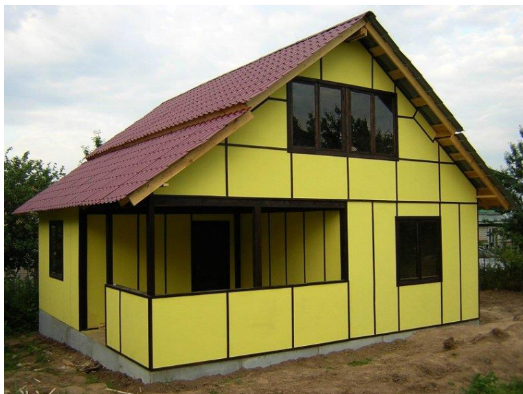
Пример отделки фасада дома с использованием материала ОГНЕЗ-ВИАН-400В
